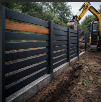
Montaż Szybka i solidna realizacja
